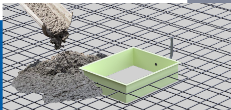
케이싱은 슬라브 콘크리트 타설 시 '내리고'가 설치될 개구부의 정확한 형태/규격을 유지시켜 주는 틀입니다
